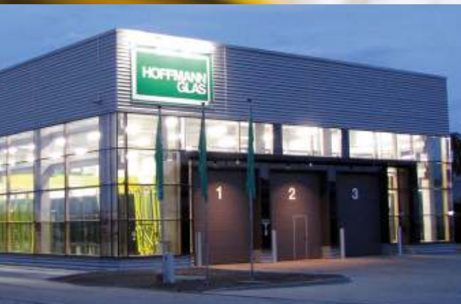
Das Werk Halle/Peißen der HoffmannGlas Gruppe: Im Mittelpunkt steht das anspruchsvolle Objektgeschäft.
